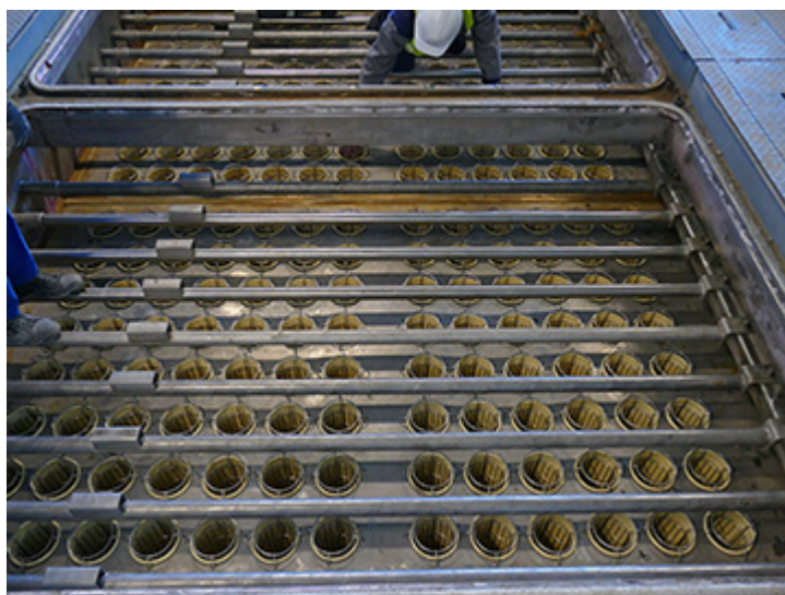
WORKI W FILTRZE WORKOWYM
