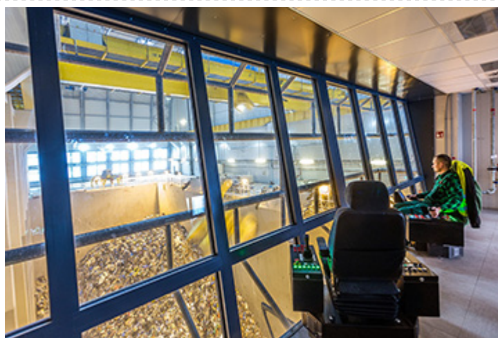
KABINA SUWNICOWA - BUNKIER NA ODPADY
